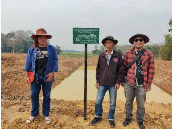
กิจกรรม “ก่อสร้างแหล่งน้ำในไร่นา ขนาด ๑,๒๖๐ ลบ.”
