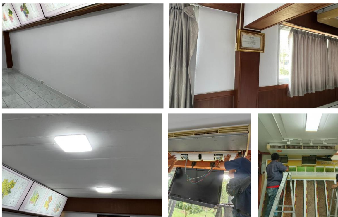
ภาพที่ ๘ การปรับปรุงผนังห้อง ฉาบ และทาสีภายในห้องโสตศึกษาและห้องพิพิธภัณฑ์ดิน ติดตั้งระบบไฟเพดาน LED และซ่อมบำรุงรักษาเครื่องปรับอากาศภายในห้องพิพิธภัณฑ์ดิน สำนักงานพัฒนาที่ดินเขต ๑
