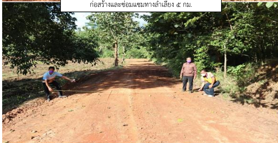
ภาพที่ ๑๘ การปรับปรุงซ่อมแซมระบบอนุรักษ์ดินและน้ำ และก่อสร้างเส้นทางลำเลียง
