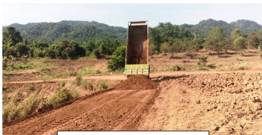
ก่อสร้างและซ่อมแซมทางลำเลียง ๕ กม.
