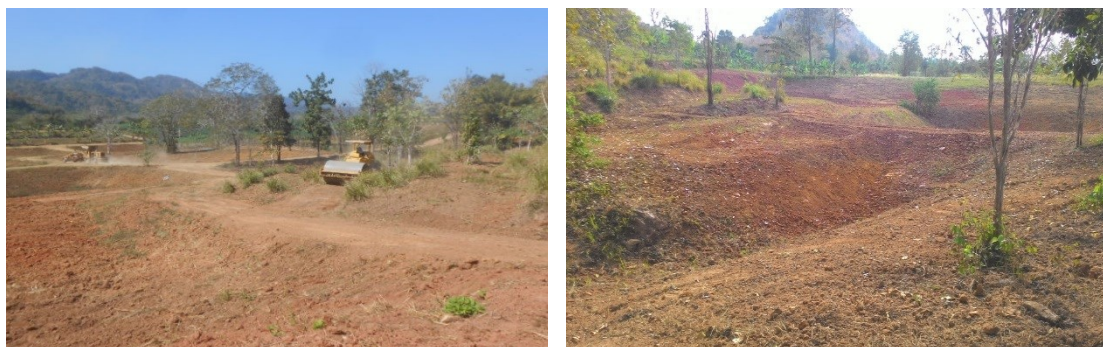
ซ่อมแซมระบบอนุรักษ์ดินและน้ำ
