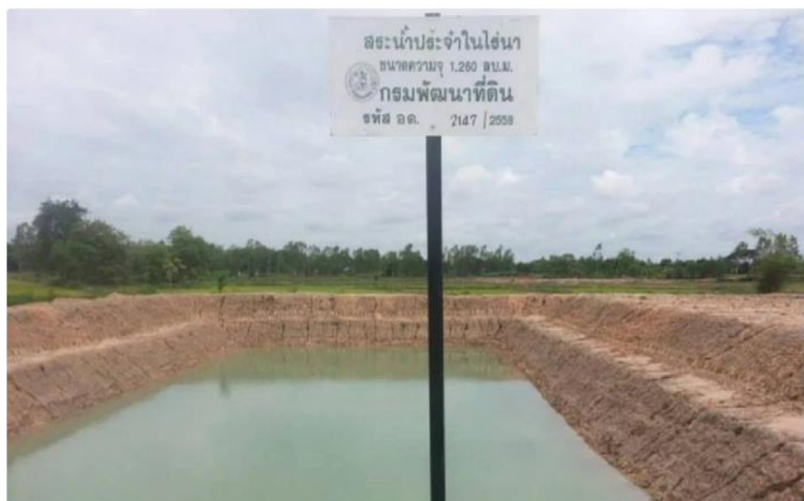
สระน้ำที่ทำการขุดเรียบร้อยแล้วพร้อมทั้งปล่อยน้ำลงบ่อ
