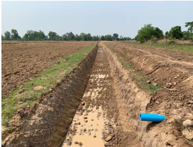
ภาพที่ 57 การปรับระดับพื้นที่นาแบบมีคูน้ำ โครงการจัดระบบอนุรักษ์ดินและน้ำพื้นที่ลุ่ม-ดอน
