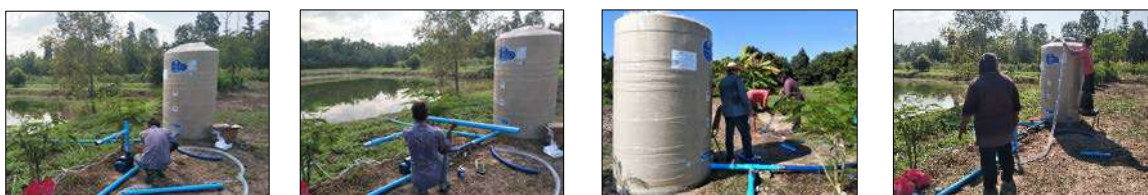
การติดตั้งระบบน้ำ
