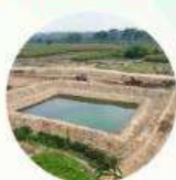
บ่อดักตะกอน
