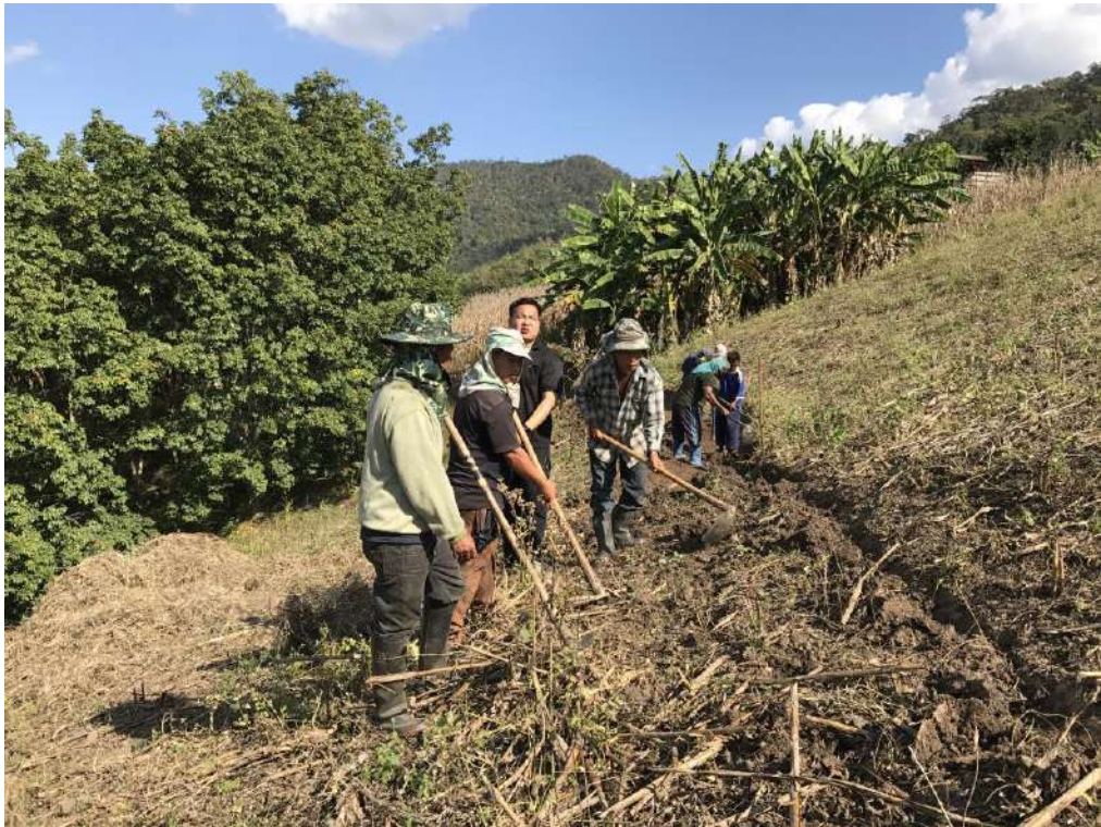
รูปที่ 4-11 ก่อสร้างคันคูแบนน้ำ
