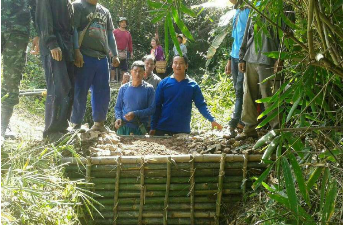
รูปที่ 4-21 งานก่อสร้างอาคารชะลอน้ำชั่วคราว 70 ฝ่าย ถวายพ่อหลวง
