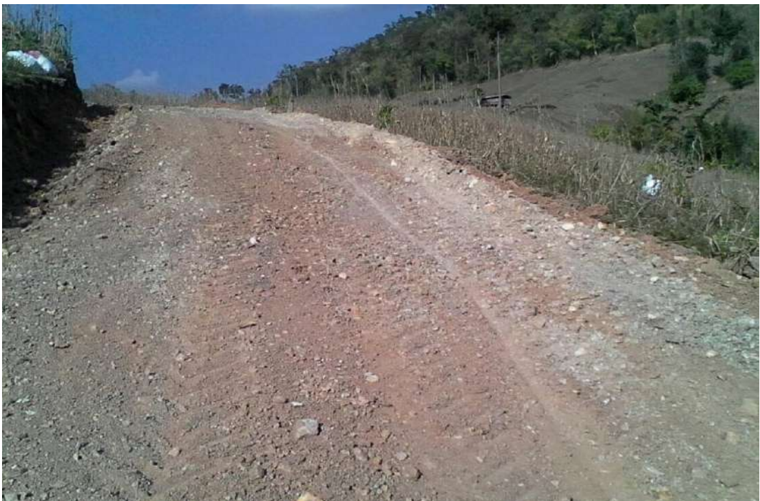
รูปที่ 4-16 กิจกรรมการก่อสร้างทางลำเลียงในไร่นา บ้านทุ่งดินดำ ม.6 ต.เมืองนะ อ.เชียงดาว จ.เชียงใหม่
