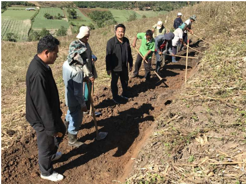
รูปที่ 4-6 การดำเนินการก่อสร้างคูรับน้ำขอบเขาแบบที่ 5
