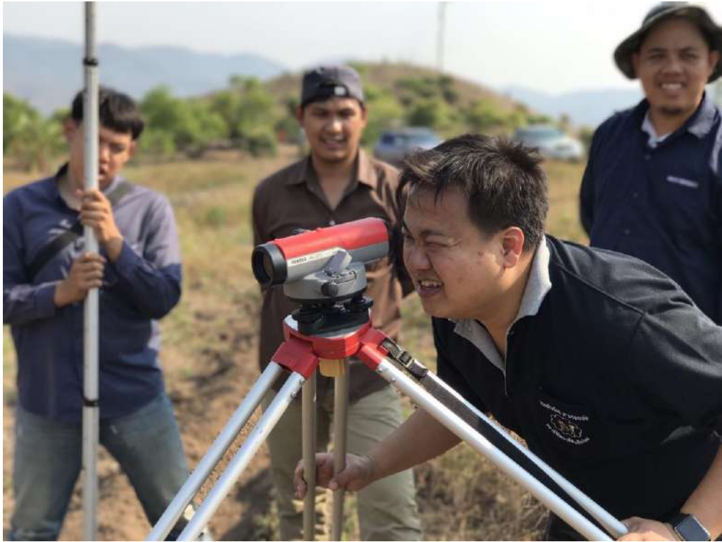
รูปที่ 4-5 ส่องกล้องวางแนวระดับคูรับน้ำขอบเขาแบบที่ 5
