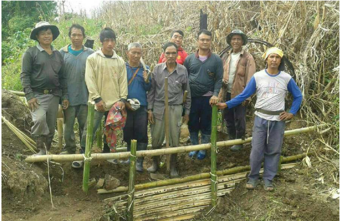
รูปที่ 4-20 งานก่อสร้างอาคารชะลอน้ำชั่วคราว 70 ฝ่าย ถวายพ่อหลวง
