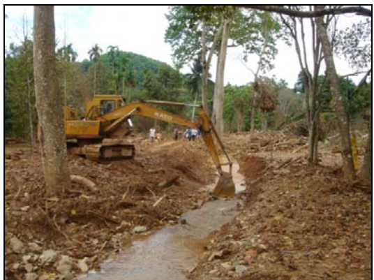
การขุดลอกตะกอนดินรอบโคนต้น และทำร่องระบายน้ำ
