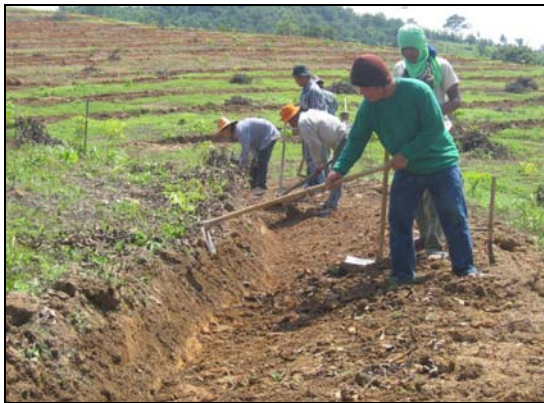
การจัดทำขั้นบันไดดิน และคูรับน้ำรอบเขาโดยใช้เครื่องจักรและแรงงาน
