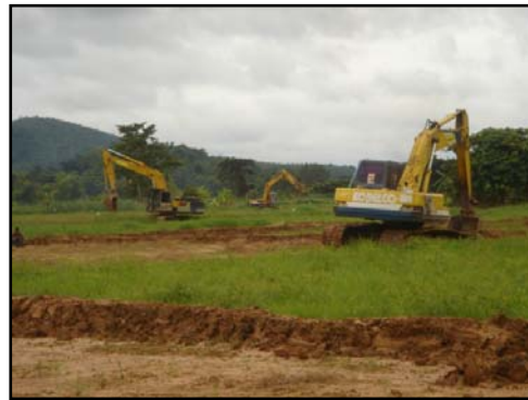
การสร้างคันนา โดยใช้รถขุดตัก เนื่องจากอุปสรรคประเภทอื่นดำเนินการไม่ได้
