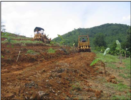
การจัดทำขั้นบันไดดิน และคูรับน้ำรอบเขาโดยใช้เครื่องจักรและแรงงาน
