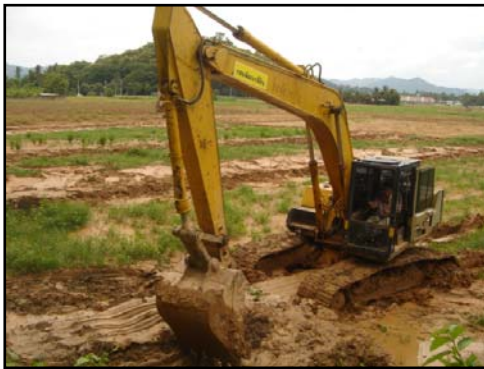
การสร้างคันนา โดยใช้รถขุดตัก เนื่องจากอุปสรรคประเภทอื่นดำเนินการไม่ได้
