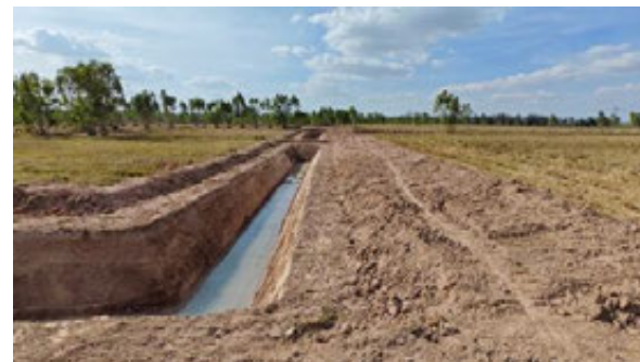
ภาพที่ 4-54 งานปรับระดับพื้นที่นาแบบมีคูน้ำ บ้านชำแระ หมู่ที่ 10 ต.หนองเต็ง อ.กระสัง
