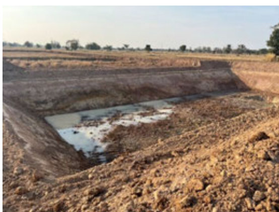
ภาพที่ 4-29 งานบ่อดักตะกอนดิน บ้านบุตาริต หมู่ที่ 12 ต.ทะเลน้อย อ.ลำปลายมาศ
