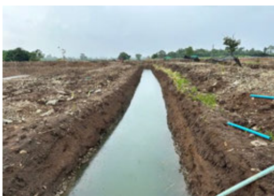
ภาพที่ 4-15 งานปรับระดับพื้นที่นาแบบมีคูน้ำ บ้านโคกมะม่วง หมู่ที่ 3 และบ้านเทพเจริญ หมู่ที่ 11 ต.โคกมะม่วง อ.ปะคำ
