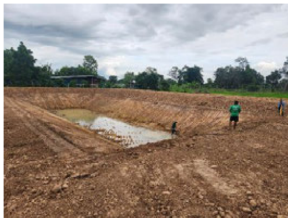
ภาพที่ 4-35 งานบ่อดักตะกอนดิน ขนาด 850 ลบ.ม. บ้านตาแก หมู่ที่ 2 และบ้านโคกเพชร หมู่ที่ 12 ต.โคกขมิ้น อ.พลับพลาชัย
