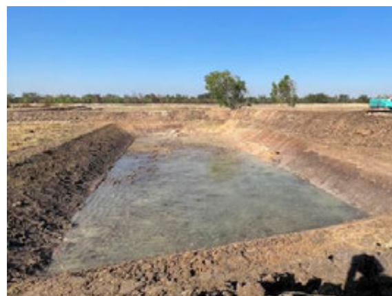
ภาพที่ 4-62 งานบ่อดักตะกอนดิน ขนาด 850 ลบ.ม. บ้านจอกเตี้ย หมู่ที่ 13 ต.หายโศก อ.พุทไธสง
