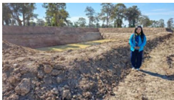
ภาพที่ 4-48 งานบ่อดักตะกอนดิน ขนาด 850 ลบ.ม. บ้านปรือ หมู่ที่ 1 ต.บ้านปรือ อ.กระสัง
