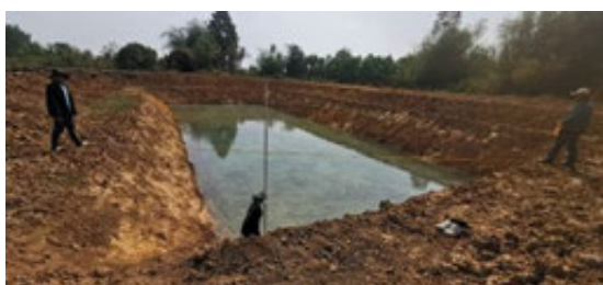
ภาพที่ 4-42 งานบ่อดักตะกอนดิน ขนาด 850 ลบ.ม. บ้านหนองบัว หนองกง หมู่ที่ 6 ต.ทุ่งแสงทอง อ.นางรอง
