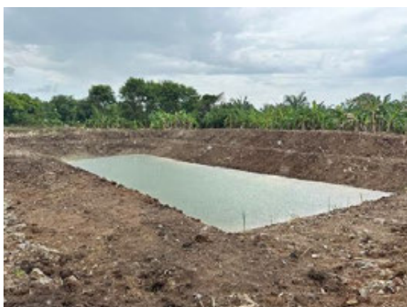
ภาพที่ 4-16 งานบ่อดักตะกอนดิน บ้านโคกมะม่วง หมู่ที่ 3 และบ้านเทพเจริญ หมู่ที่ 11 ต.โคกมะม่วง อ.ปะคำ
