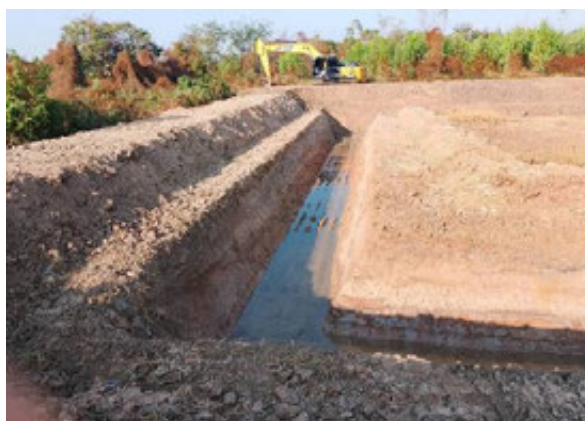
ภาพที่ 4-61 งานปรับระดับพื้นที่นาแบบมีคูน้ำ บ้านจอกเตี้ย หมู่ที่ 13 ต.หายโศก อ.พุทไธสง
