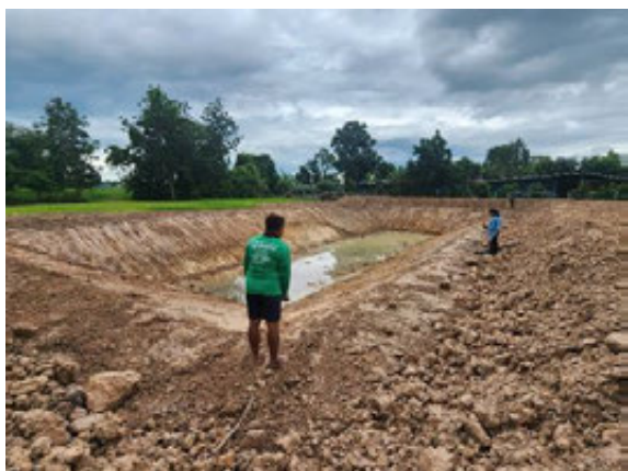
ภาพที่ 4-35 งานบ่อดักตะกอนดิน ขนาด 850 ลบ.ม. บ้านตาแก หมู่ที่ 2 และบ้านโคกเพชร หมู่ที่ 12 ต.โคกขมิ้น อ.พลับพลาชัย
