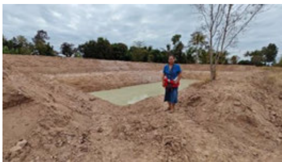
ภาพที่ 4-48 งานบ่อดักตะกอนดิน ขนาด 850 ลบ.ม. บ้านปรือ หมู่ที่ 1 ต.บ้านปรือ อ.กระสัง
