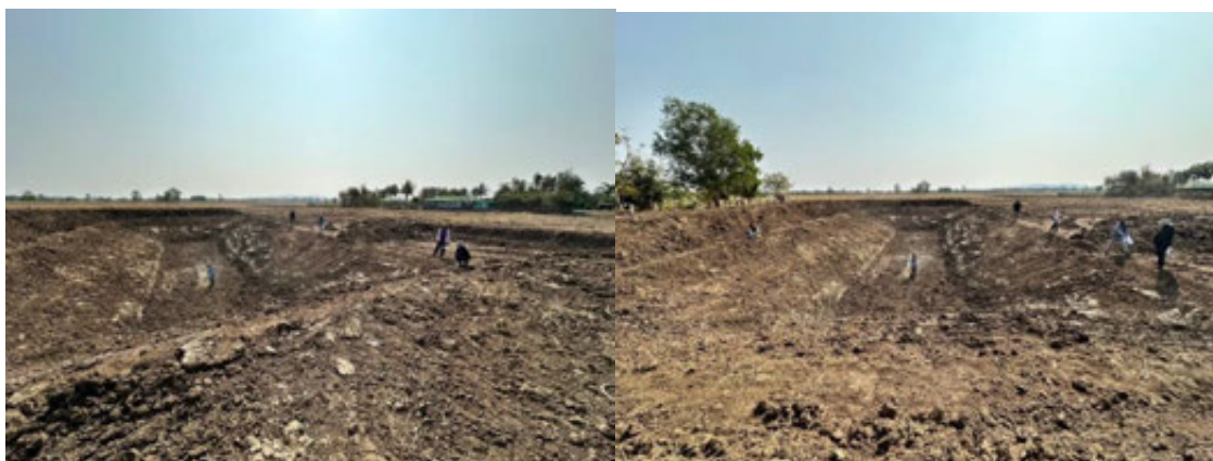
ภาพที่ 4-22 งานบ่อดักตะกอนดิน ขนาด 850 ลบ.ม. บ้านโคกศรีละคร หมู่ที่ 3 และบ้านหนองแห้ว หมู่ที่ 11 ต.เจริญสุข อ.เฉลิมพระเกียรติ
