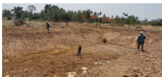
ภาพที่ 4-42 งานบ่อดักตะกอนดิน ขนาด 850 ลบ.ม. บ้านหนองบัว หนองกง หมู่ที่ 6 ต.ทุ่งแสงทอง อ.นางรอง
