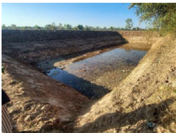
ภาพที่ 4-62 งานบ่อดักตะกอนดิน ขนาด 850 ลบ.ม. บ้านจอกเตี้ย หมู่ที่ 13 ต.หายโศก อ.พุทไธสง
