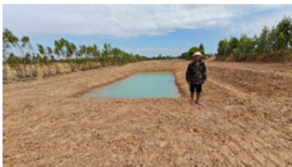
ภาพที่ 4-55 งานบ่อดักตะกอนดิน ขนาด 850 ลบ.ม. บ้านชำแระ หมู่ที่ 10 ต.หนองเต็ง อ.กระสัง
