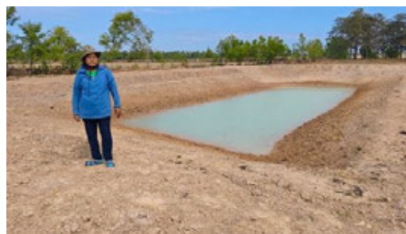
ภาพที่ 4-55 งานบ่อดักตะกอนดิน ขนาด 850 ลบ.ม. บ้านชำแระ หมู่ที่ 10 ต.หนองเต็ง อ.กระสัง
