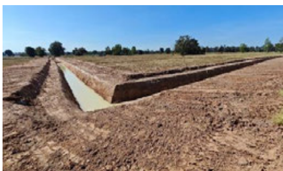
ภาพที่ 4-54 งานปรับระดับพื้นที่นาแบบมีคูน้ำ บ้านชำแระ หมู่ที่ 10 ต.หนองเต็ง อ.กระสัง
