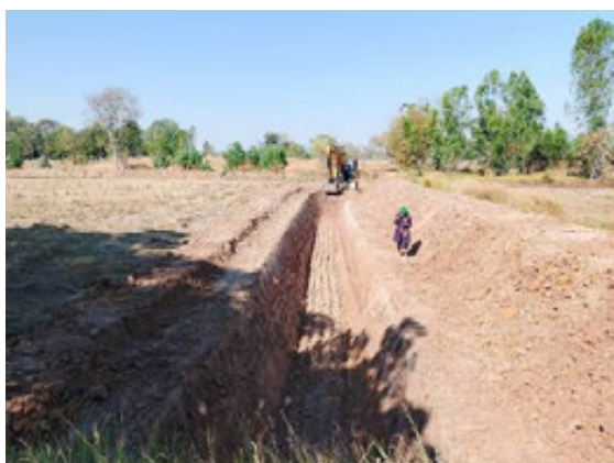
ภาพที่ 4-61 งานปรับระดับพื้นที่นาแบบมีคูน้ำ บ้านจอกเตี้ย หมู่ที่ 13 ต.หายโศก อ.พุทไธสง
