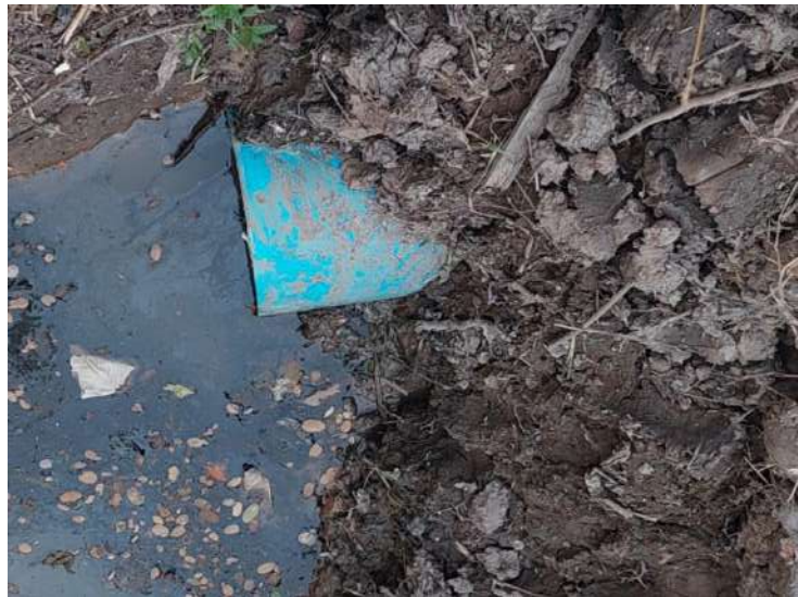
ภาพที่ ๔ ท่อระบายน้ำ
